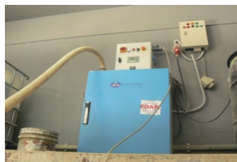
b. Generator set.
